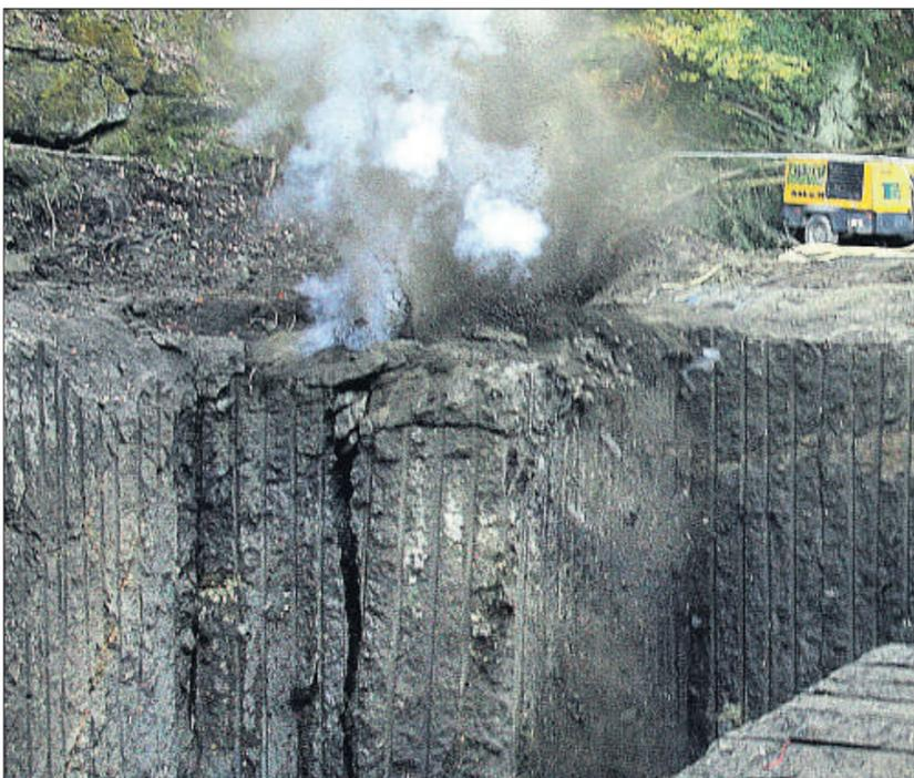
Die Sprengung: Mit dünnen Schnüren, die Schwarzpulver enthalten, wird eine weitere Schicht der Tuffsteinwand gelockert.
