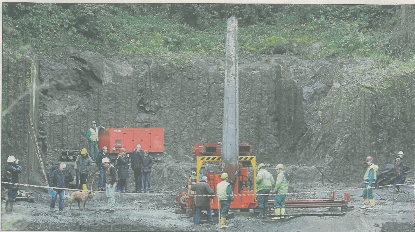
Abbau mit Spezialsäge: Sechs Meter lang ist das Schwert der Maschine, mit der der Tuffstein am Kuhberg abgebaut wird. 8600 von insgesamt 10 000 Kubikmetern Tuff sind bereits abgebaut.
